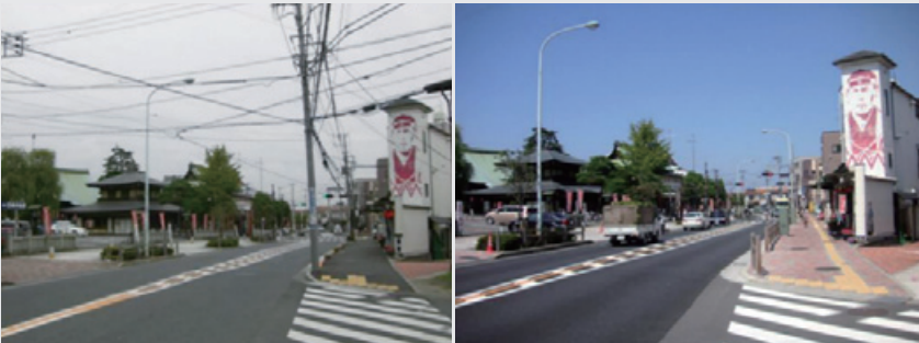
拆除前与拆除后（来源：东京都政府）
